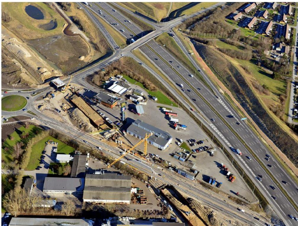
Cementvej, Solrød – februar 2016
