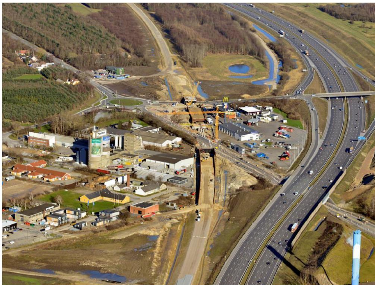
Cementvej, Solrød – februar 2016
