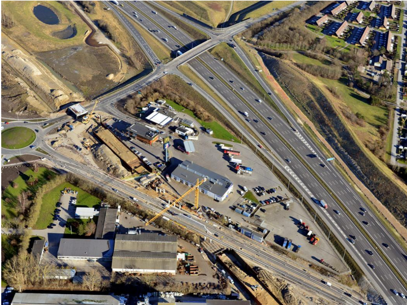
Cementvej, Solrød – februar 2016
