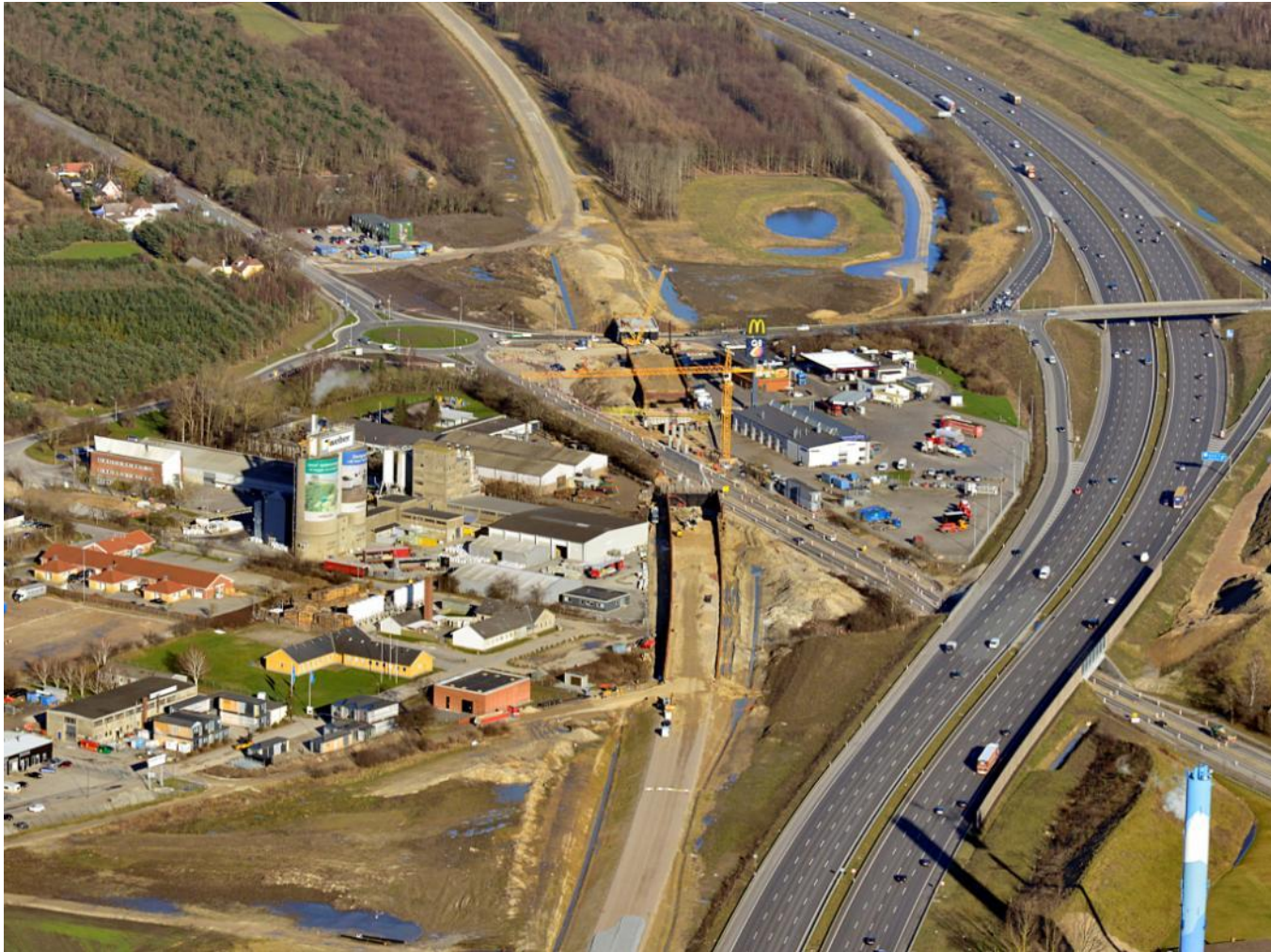
Cementvej, Solrød – februar 2016
