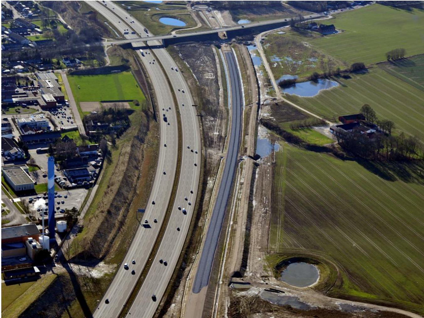
Cementvej, Solrød – februar 2016
